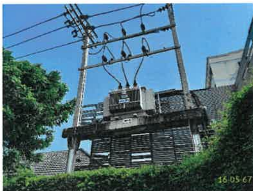
หม้อแปลงไฟฟ้า อาคาร 7
