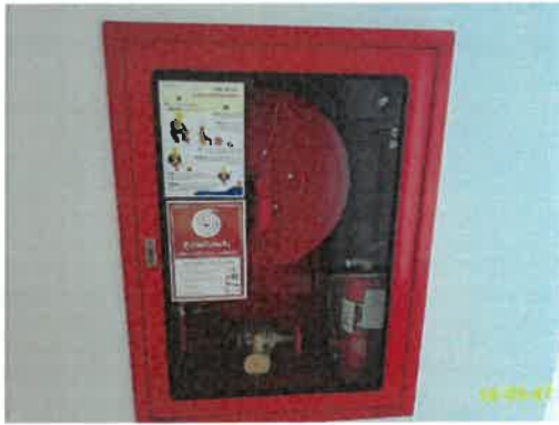
ตู้สายน้ำดับเพลิง และป้ายบอกวิธีการใช้อุปกรณ์
